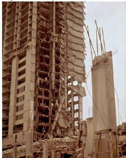
*Uma estrutura de lajes lisas de concreto armado sofreu colapso progressivo vertical e horizontal, durante a construção do 24º pavimento*
