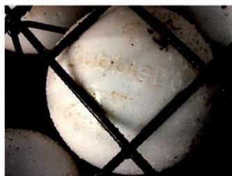
BubbleDeck® é um sistema construtivo composto por esferas plásticas inseridas uniformemente entre duas armaduras. As esferas (bubbles) são introduzidas na intersecção das armaduras e "ocupam" a zona de concreto que não desempenha função estrutural.
