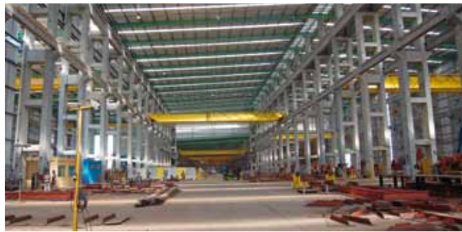
Galpão Área 5 do Estaleiro Atlântico Sul
