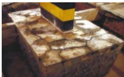
Bloco de fundação RAA (2)
