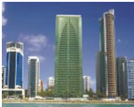
Edifícios Brennand Plaza (centro) e Estação do Mar (à direita), Recife, PE
