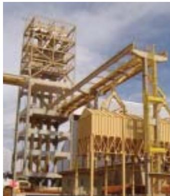
*Torre pré-moldada/metálica em Carazinho (MT)
